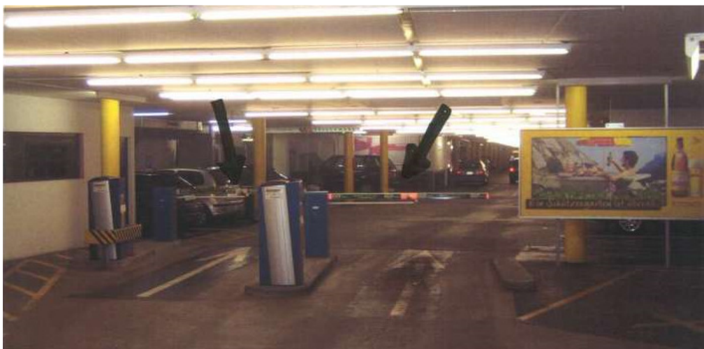
Parkgarage Burggraben, 9000 St. Gallen
